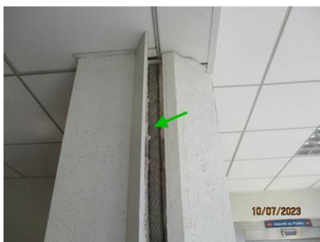
Matériaux : ZPSO-044 Prélèvement : P044 Description : Joint de dilatation Localisation : NIVEAU 2 - K299 Résultat : Absence d'amiante
