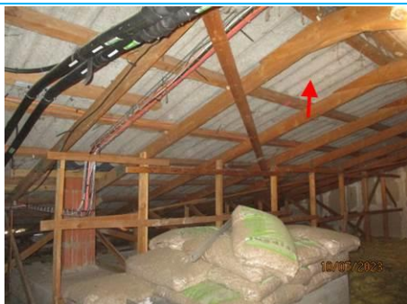
Matériaux : ZPSO-005 Prélèvement : P005 Description : Plaques ondulées en fibres-ciment Localisation : COMBLES - COMBLES 1 Résultat : Présence d'amiante
