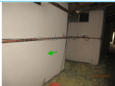
Matériaux : ZPSO-021 Prélèvement : P021 Description : Enduits coffrage Localisation : COMBLES - COMBLES 2 Résultat : Absence d'amiante
