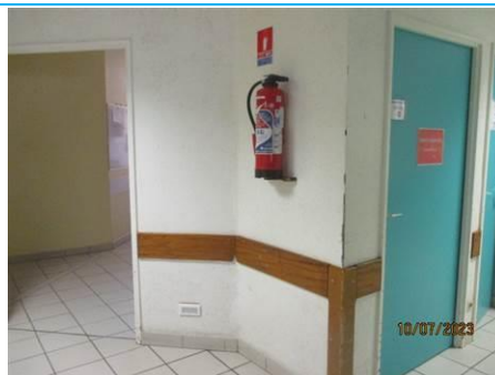
Matériaux : ZPSO-054 Prélèvement : P054 Description : Enduit CLOISON Localisation : NIVEAU 2 - K299; NIVEAU 2 - HALL M247; NIVEAU 2 - K298; NIVEAU 2 - K286; NIVEAU 2 - M239 Résultat : Absence d'amiante
