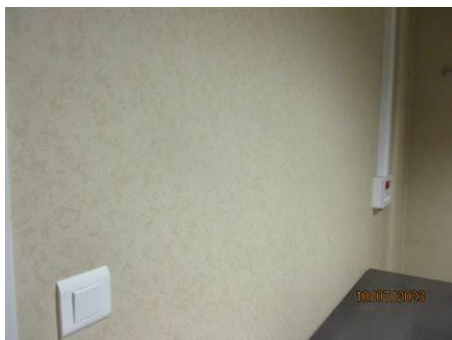
Matériaux : ZPSO-080 Prélèvement : P080 Description : Enduits +REVETEMENT CLOISON Localisation : NIVEAU 2 - M223 Résultat : Absence d'amiante
