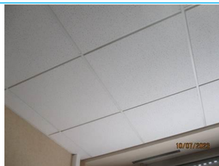
Matériaux : ZPSO-077 Prélèvement : P077 Description : FAUX-PLAFOND Localisation : NIVEAU 2 - M223 Résultat : Absence d'amiante
