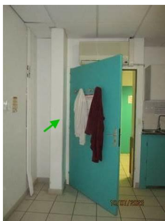
Matériaux : ZPSO-060 Prélèvement : P060 Description : Enduit POTEAU Localisation : NIVEAU 2 - K271 Résultat : Absence d'amiante
