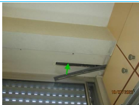
Matériaux : ZPSO-092 Prélèvement : P092 Description : COLLE ISOLANT COFFRE VOLET ROULANT Localisation : NIVEAU 1 - S102; Niveau 1 - S103; Niveau 1 - S104; Niveau 1 - S105; NIVEAU 1 - S106; NIVEAU 1 - S107; NIVEAU 1 - S110 à S113; NIVEAU 1 - S114; NIVEAU 1 - SAM S115; NIVEAU 1 - S120; Niveau 1 - S121; NIVEAU 1 - S122 à S127 Résultat : Absence d'amiante
