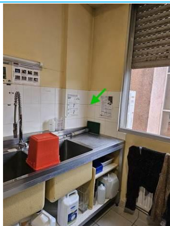
Matériaux : ZPSO-108 Prélèvement : P105 Description : Colle de faïence Localisation : Niveau 1 - S121 Résultat : Absence d'amiante
