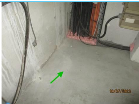
Matériaux : ZPSO-028 Prélèvement : P028 Description : Chape Localisation : COMBLES - ACCES COMBLES Résultat : Absence d'amiante
