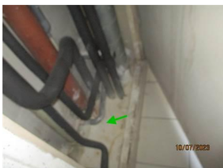
Matériaux : ZPSO-081 Prélèvement : P081 Description : Ragréage Localisation : NIVEAU 2 - GT Résultat : Absence d'amiante
