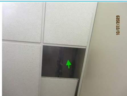
Matériaux : ZPSO-095 Prélèvement : P095 Description : Enduit PLAFOND Localisation : NIVEAU 1 - S118 Résultat : Absence d'amiante
