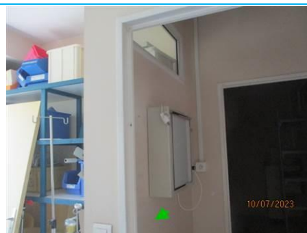
Matériaux : ZPSO-075 Prélèvement : P075 Description : Enduits CLOISON Localisation : NIVEAU 2 - M223; NIVEAU 2 - M224 Résultat : Absence d'amiante
