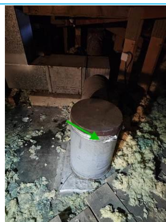
Matériaux : ZPSO-019 Prélèvement : P150 Description : Ruban adhésif Localisation : COMBLES - COMBLES 2 Résultat : Absence d'amiante
