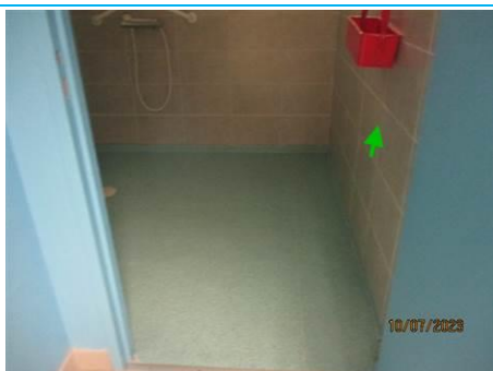
Matériaux : ZPSO-050 Prélèvement : P050 Description : Colle de faïence Localisation : NIVEAU 2 - K278; NIVEAU 2 - M225 Résultat : Absence d'amiante
