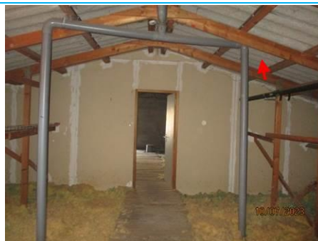
Matériaux : ZPSO-005 Prélèvement : P013 Description : Plaques ondulées en fibres-ciment Localisation : COMBLES - COMBLES 2 Résultat : Présence d'amiante
