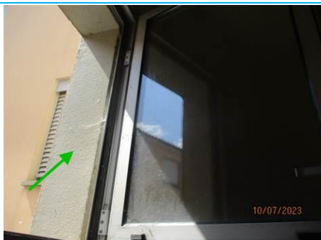
Matériaux : ZPSO-102 Prélèvement : P102 Description : Enduit extérieur Localisation : EXTERIEUR - FACADE Résultat : Absence d'amiante
