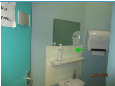
Matériaux : ZPSO-055 Prélèvement : P055 Description : Colle de faïence Localisation : Niveau 2 - K282 Résultat : Absence d'amiante
