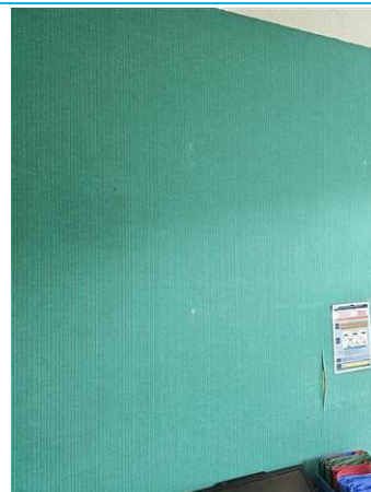
Matériaux : ZPSO-146 Prélèvement : P142 Description : Sous couche de moquette murale M227 Localisation : NIVEAU 2 - M226 ET 227 Résultat : Absence d'amiante
