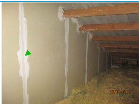
Matériaux : ZPSO-009 Prélèvement : P009 Description : Enduit de jointoiment des plaques de plâtre Localisation : COMBLES - COMBLES 2 Résultat : Absence d'amiante
