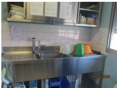
Matériaux : ZPSO-053 Prélèvement : P053 Description : Colle de faïence blanche Localisation : NIVEAU 2 - K274 Résultat : Absence d'amiante
