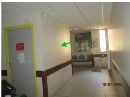
Matériaux : ZPSO-072 Prélèvement : P072 Description : Enduit MUR Localisation : NIVEAU 2 - M239 Résultat : Absence d'amiante
