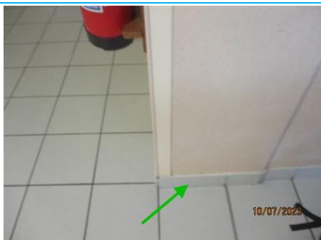
Matériaux : ZPSO-096 Prélèvement : P096 Description : Colle de PLINTHE Localisation : NIVEAU 1 - SAM S115 Résultat : Absence d'amiante
