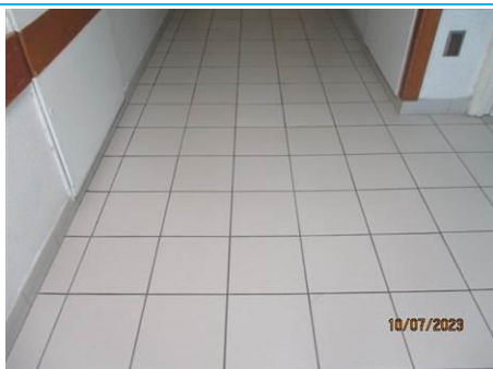
Matériaux : ZPSO-029 Prélèvement : P029 Description : Colle de carrelage Localisation : NIVEAU 2 - K299; NIVEAU 2 - HALL M247; NIVEAU 2 - M248; Niveau 2 - K266; NIVEAU 2 - K298; NIVEAU 2 - K274; NIVEAU 2 - K278; NIVEAU 2 - K271; Niveau 2 - K282; Niveau 2 - K283; NIVEAU 2 - K286; NIVEAU 2 - K277 ET K257; NIVEAU 2 - DETENTE M246 Résultat : Absence d'amiante
