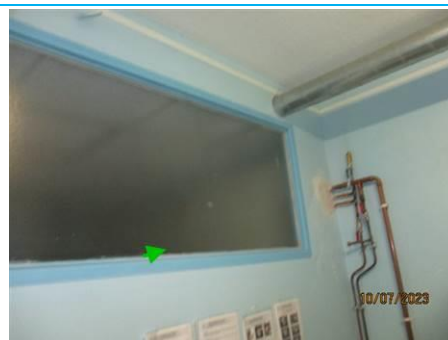
Matériaux : ZPSO-051 Prélèvement : P051 Description : Joint de mastic de vitrage Intérieur Localisation : NIVEAU 2 - K274; NIVEAU 2 - K278 Résultat : Absence d'amiante
