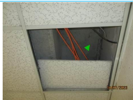
Matériaux : ZPSO-032 Prélèvement : P032 Description : Enduit BETON PLAFOND Localisation : NIVEAU 2 - K299; NIVEAU 2 - HALL M247; NIVEAU 2 - K286; NIVEAU 2 - M239 Résultat : Absence d'amiante
