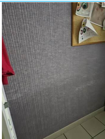
Matériaux : ZPSO-146 Prélèvement : P143 Description : Sous couche de moquette murale Localisation : NIVEAU 2 - M226 Résultat : Absence d'amiante
