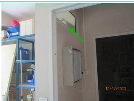
Matériaux : ZPSO-076 Prélèvement : P076 Description : Joint de mastic de vitrage INTERIEUR Localisation : NIVEAU 2 - M224 Résultat : Absence d'amiante
