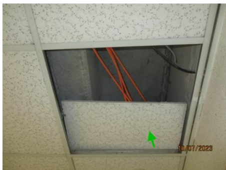
Matériaux : ZPSO-031 Prélèvement : P031 Description : FAUX-PLAFOND Localisation : NIVEAU 2 - K286 Résultat : Absence d'amiante
