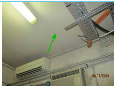
Matériaux : ZPSO-027 Prélèvement : P027 Description : Enduit PLAFOND Localisation : COMBLES - ACCES COMBLES Résultat : Absence d'amiante
