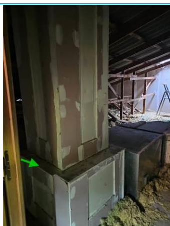
Matériaux : ZPSO-153 Prélèvement : P149 Description : Enduit Coffrage Localisation : COMBLES - COMBLES 1 Résultat : Absence d'amiante
