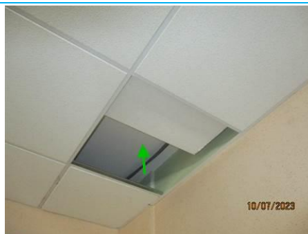
Matériaux : ZPSO-100 Prélèvement : P100 Description : Enduit PLAFOND Localisation : NIVEAU 1 - SAM S115 Résultat : Absence d'amiante
