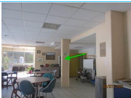
Matériaux : ZPSO-099 Prélèvement : P099 Description : Enduit POTEAU Localisation : NIVEAU 1 - SAM S115 Résultat : Absence d'amiante
