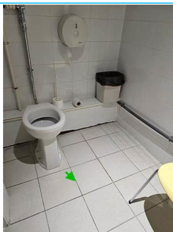
Matériaux : ZPSO-106 Prélèvement : P103 Description : Joint de carrelage Localisation : NIVEAU 1 - S118 Résultat : Absence d'amiante
