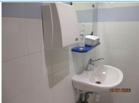
Matériaux : ZPSO-093 Prélèvement : P093 Description : Colle de faïence Localisation : NIVEAU 1 - S118 Résultat : Absence d'amiante
