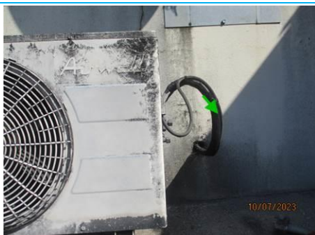
Matériaux : ZPSO-024 Prélèvement : P024 Description : Calorifuge SPLIT Localisation : TOITURE - TOITURE-TERRASSE Résultat : Absence d'amiante
