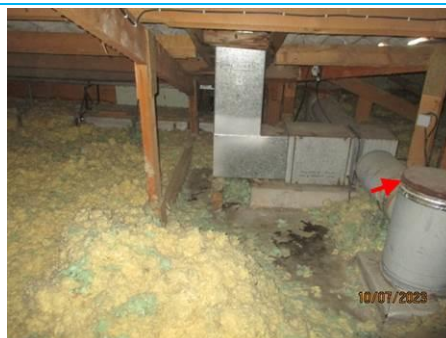
Matériaux : ZPSO-019 Prélèvement : P019 Description : Ruban adhésif Localisation : COMBLES - COMBLES 2 Résultat : Présence d'amiante
