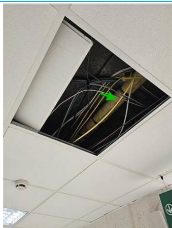
Matériaux : ZPSO-145 Prélèvement : P141 Description : Calorifuge (tresses, coquilles, matelas...) Localisation : NIVEAU 2 - M239 Résultat : Absence d'amiante
