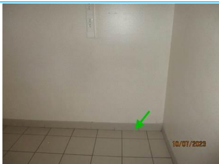
Matériaux : ZPSO-030 Prélèvement : P040 Description : Colle de PLINTHE Localisation : Niveau 2 - K266; NIVEAU 2 - K298; NIVEAU 2 - K274; NIVEAU 2 - K271; Niveau 2 - K282; Niveau 2 - K283; NIVEAU 2 - K285; NIVEAU 2 - K286; NIVEAU 2 - K277 ET K257; NIVEAU 2 - BUREAU MEDECIN; NIVEAU 2 - DETENTE M246 Résultat : Absence d'amiante
