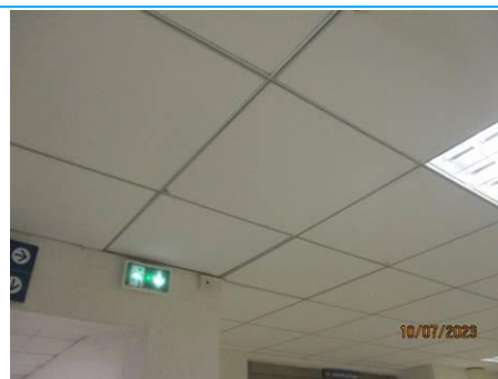
Matériaux : ZPSO-034 Prélèvement : P034 Description : FAUX-PLAFOND BLANC Localisation : NIVEAU 2 - K298; NIVEAU 2 - M239 Résultat : Absence d'amiante
