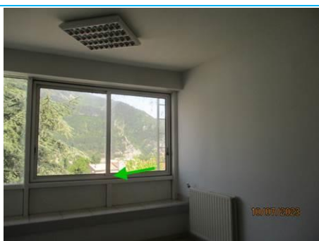
Matériaux : ZPSO-083 Prélèvement : P083 Description : Joint de mastic de vitrage Localisation : NIVEAU 2 - DETENTE M246 Résultat : Absence d'amiante
