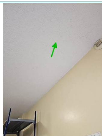
Matériaux : ZPSO-113 Prélèvement : P110 Description : Enduit plafond Localisation : Niveau 1 - S121 Résultat : Absence d'amiante
