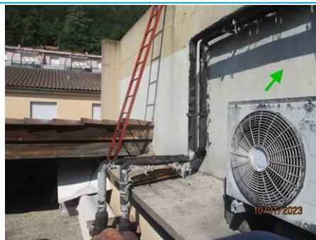
Matériaux : ZPSO-023 Prélèvement : P023 Description : Enduit extérieur Localisation : TOITURE - TOITURE-TERRASSE Résultat : Absence d'amiante
