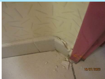
Matériaux : ZPSO-030 Prélèvement : P062 Description : Colle de PLINTHE Localisation : NIVEAU 2 - M204; NIVEAU 2 - M205; NIVEAU 2 - M200 à M203 ET M206 à M216 ET M2018; NIVEAU 2 - M219 ET M221; NIVEAU 2 - M222; NIVEAU 2 - M223; NIVEAU 2 - M224; NIVEAU 2 - M226 ET 227; NIVEAU 2 - M233; NIVEAU 2 - M239; NIVEAU 2 - M230 Résultat : Absence d'amiante
