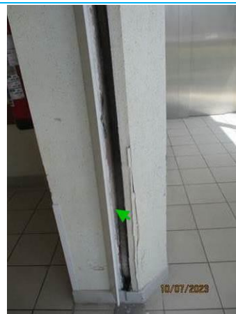
Matériaux : ZPSO-045 Prélèvement : P045 Description : Enduit MUR Localisation : NIVEAU 2 - K299 Résultat : Absence d'amiante
