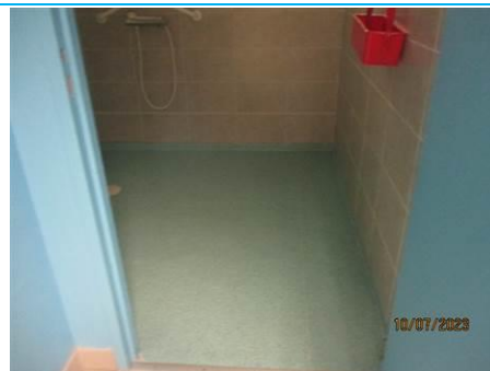
Matériaux : ZPSO-049 Prélèvement : P049 Description : Revêtement souple Localisation : NIVEAU 2 - K278; NIVEAU 2 - M225 Résultat : Absence d'amiante
