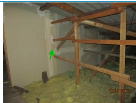
Matériaux : ZPSO-004 Prélèvement : P004 Description : Bandes calicot Localisation : COMBLES - COMBLES 1 Résultat : Absence d'amiante
