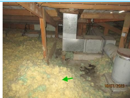
Matériaux : ZPSO-001 Prélèvement : P010 Description : Isolant fibreux JAUNE Localisation : COMBLES - COMBLES 2 Résultat : Absence d'amiante
