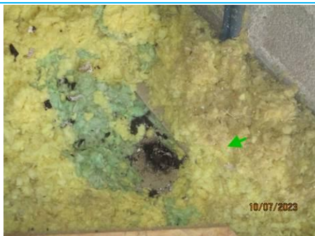
Matériaux : ZPSO-001 Prélèvement : P001 Description : Isolant fibreux JAUNE Localisation : COMBLES - COMBLES 1 Résultat : Absence d'amiante
