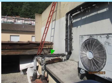
Matériaux : ZPSO-022 Prélèvement : P022 Description : Calorifuge CTA Localisation : TOITURE - TOITURE-TERRASSE Résultat : Absence d'amiante
