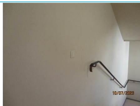
Matériaux : ZPSO-036 Prélèvement : P036 Description : Enduit MUR Localisation : Niveau 0 au niveau 2 - cage d'escalier D; NIVEAU 0 A NIVEAU 2 - CAGE ESCALIER E Résultat : Absence d'amiante
