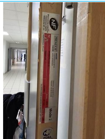
Matériaux : ZPSO-156 Prélèvement : Description : Porte coupe-feu de 2014 Localisation : NIVEAU 1 - S117 Résultat : Absence d'amiante
