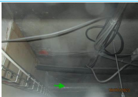
Matériaux : ZPSO-104 Prélèvement : Description : Conduit galvanisé Localisation : NIVEAU 1 ET 2 - Ensemble des conduits de ventilation des chambres Résultat : Absence d'amiante
