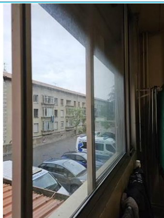
Matériaux : ZPSO-110 Prélèvement : P107 Description : Joint de mastic de vitrage (notamment châssis aluminium) Localisation : Niveau 1 - S121 Résultat : Absence d'amiante
