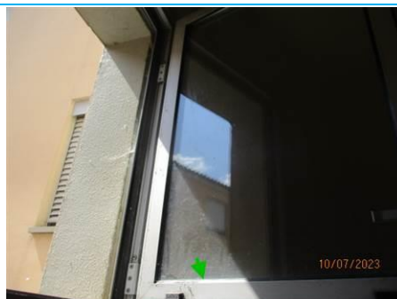
Matériaux : ZPSO-101 Prélèvement : P101 Description : Joint de mastic de vitrage Localisation : Niveau 0 au niveau 2 - cage d'escalier D Résultat : Absence d'amiante
